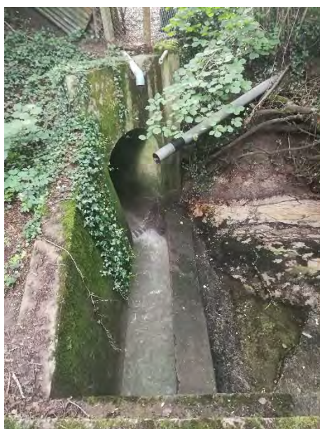
Déversoir d'orage avant les travaux
