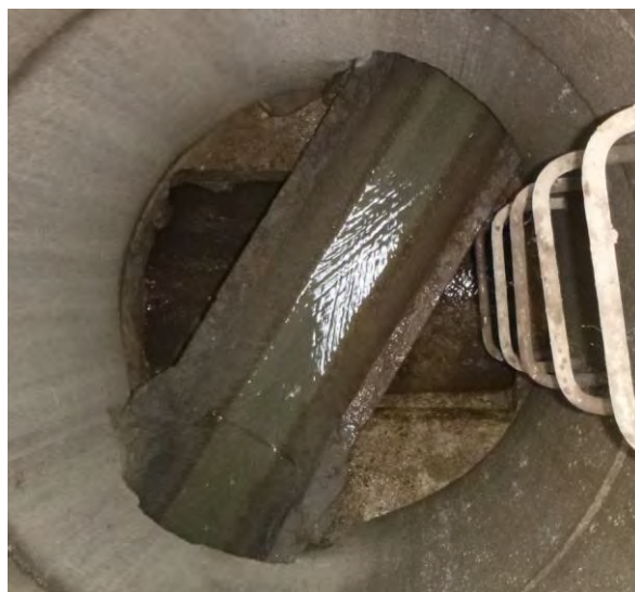
Vue de l'ouvrage de délestage sur le réseau d'eaux pluviales
