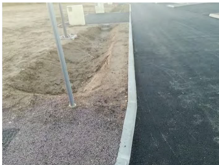
Noue de collecte
