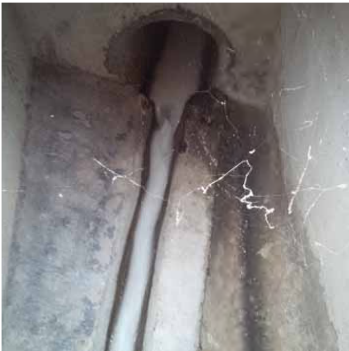
Partie amont de l'ouvrage
