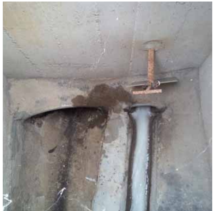
Partie aval de l'ouvrage
