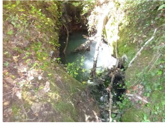
Fosse d'érosion et zone de stock des eaux usées en aval de l'exutoire
