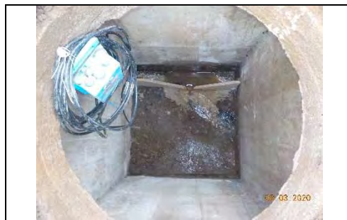
Vue du dispositif de mesure dans le regard EU85
