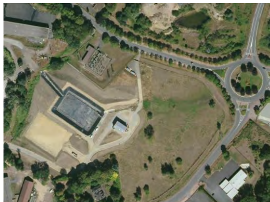
Aménagements hydrauliques récents
