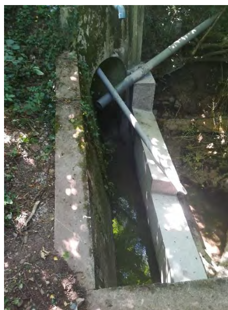
Déversoir d'orage après modification de la lame déversante
