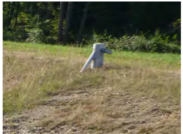
Ouvrage de vidange ?
